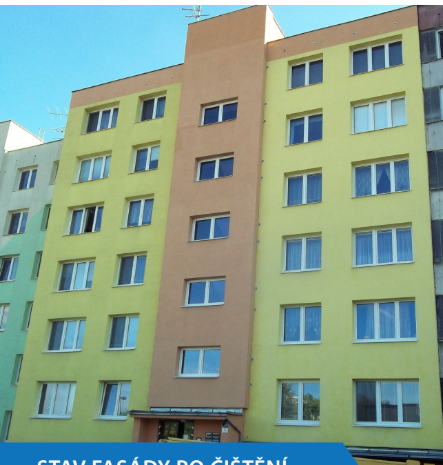
STAV FASÁDY PO ČIŠTĚNÍ.
