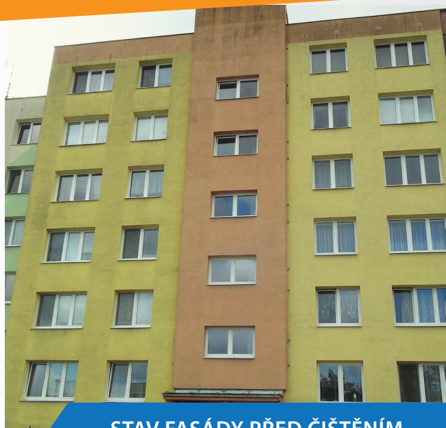
STAV FASÁDY PŘED ČIŠTĚNÍM.
